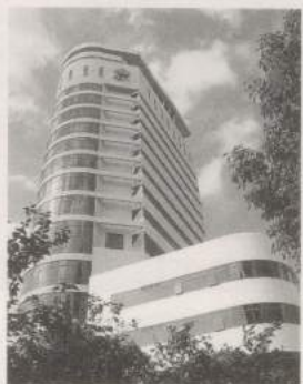
▶上海電機大学。「動漫画設計専攻」の校舎は現在新たに建設中
